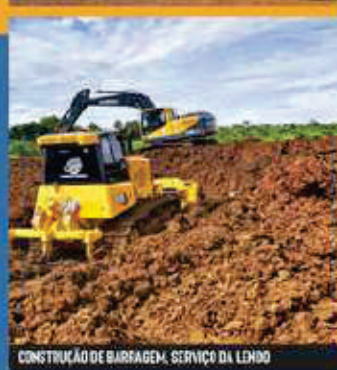
CONSTRUÇÃO DE BARRAGEM, SERVIÇO DA LENDO
